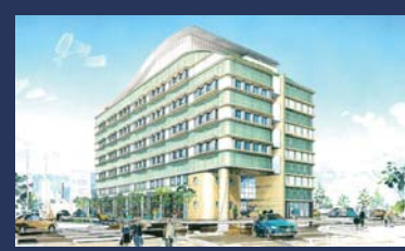
滋賀県労働総合庁舎
